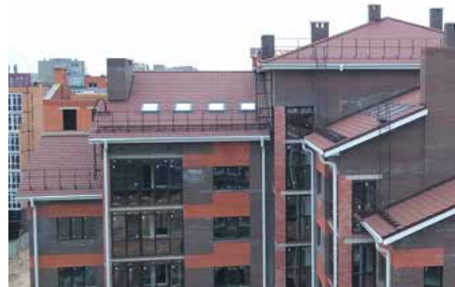
Рис. 19. Фасадные лестницы на жилом доме
