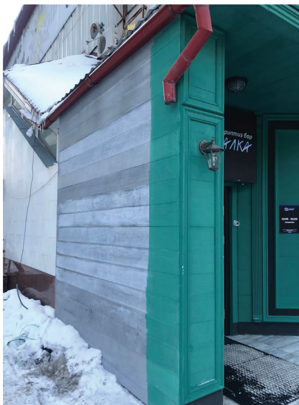
Оформление входной группы серой фасадной доской и последующим окрашиванием в насыщенный бирюзово-зеленый цвет.
