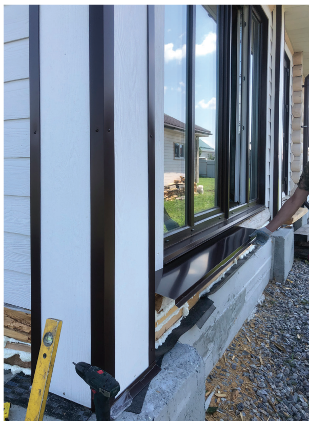
Монтаж кровельного карниза из белой ДФТ шириной 190 мм. Монтаж оконных наличников из белой доборной фасадной доски шириной 100 мм.
