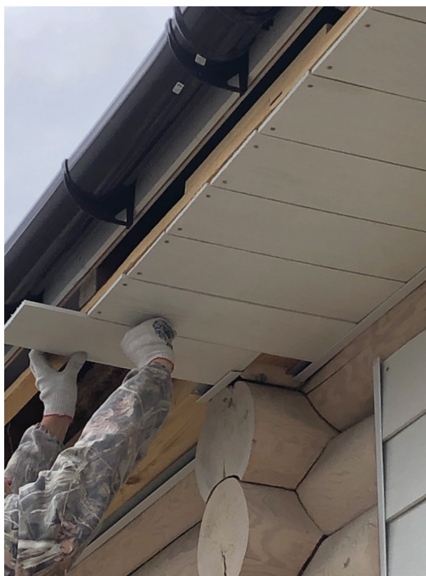
Монтаж кровельного карниза из белой ДФТ шириной 190 мм. Монтаж оконных наличников из белой доборной фасадной доски шириной 100 мм.
