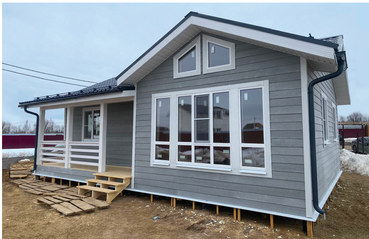
На фасаде дома серая неокрашенная фасадная доска шириной 190 мм.
