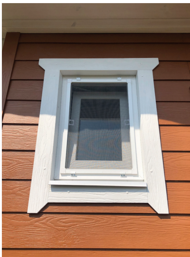
Фасад с применением серой доски шириной 190 мм. После монтажа доску окрасили в светло-терракотовый цвет. Наличники оформлены серой доборной доской (ДДФТ), запилены под углом 45° и после монтажа окрашены в белый цвет.
