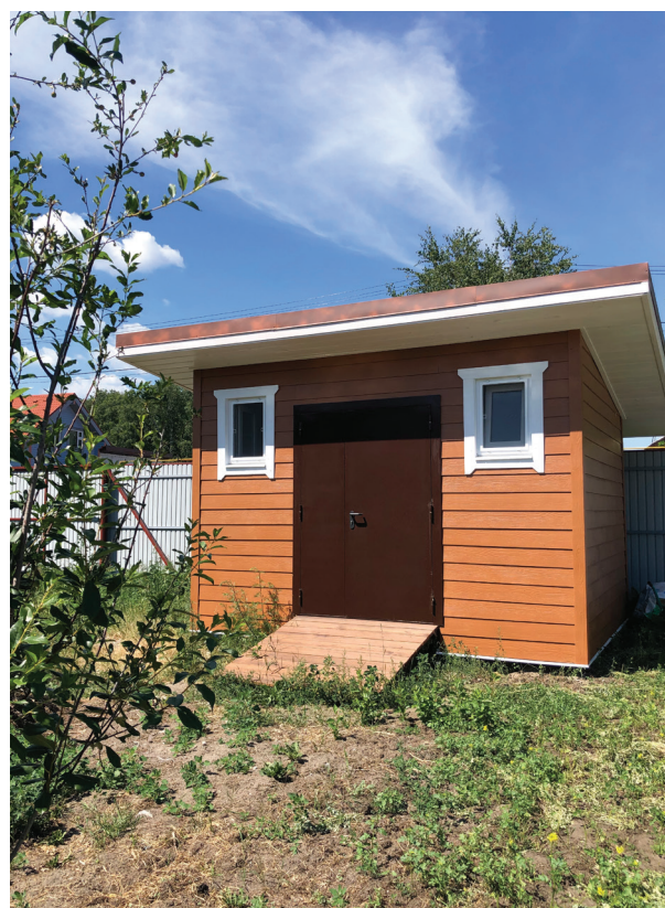
Фасад с применением серой доски шириной 190 мм. После монтажа доску окрасили в светло-терракотовый цвет. Наличники оформлены серой доборной доской (ДДФТ), запилены под углом 45° и после монтажа окрашены в белый цвет.
