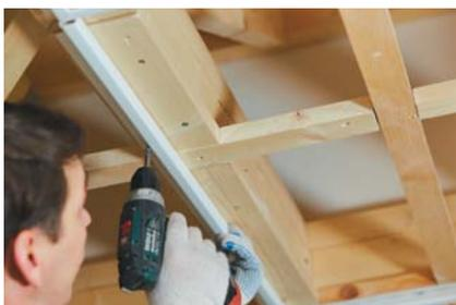
**2.2.5** Далее производится установка панелей софитов, которые должны быть подрезаны таким образом, чтобы их ширина была примерно на 1 см меньше, чем расстояние между внешними краями J-профилей.
