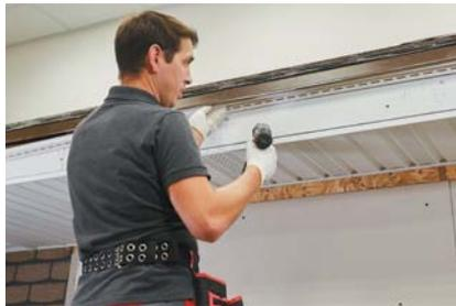
**3.2** После монтажа финишного профиля монтируется J-фаска. Она должна быть подрезана по высоте лобовой доски. Затем в ее верхней части необходимо сделать засечки для фиксации в финишном профиле. После этого J-фаска фиксируется саморезами к нижней части лобовой доски.
