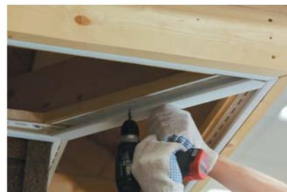
**2.2.2** Установка H-профиля, предназначенного для соединения панелей в угловых зонах. Панели в данном случае подрезаем с учетом этого угла «елочкой». Фиксируем саморезами к обрешетке и стыкуем.
