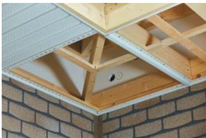
**2.2.4** Второй вариант прямого соединения – при помощи J-профиля. Его устанавливаем от угла перпендикулярно одному из свесов карниза. Фиксируем саморезами к обрешетке и стыкуем друг с другом.
