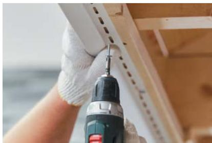
**3.3** Далее производится установка панелей софитов, которые должны быть подрезаны таким образом, чтобы их ширина была примерно на 1 см меньше, чем расстояние между внешними краями J-профиля и J-фаски.
