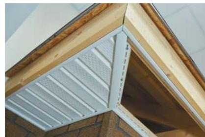
**2.2.3** Прямое соединение выполняется с помощью Н-профиля. Его монтируем от внутреннего угла перпендикулярно одному из свесов карниза.
