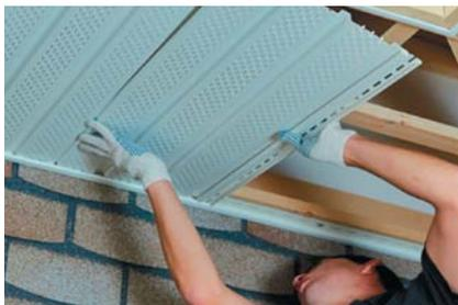
Для более удобного монтажа рекомендуется подрезать панель таким образом, чтобы длина панели была немного меньше расстояния между J-профилями. Длину панели лучше определить опытным путем после монтажа первой панели на свесе.
