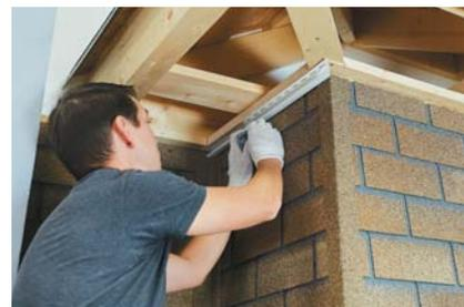
**2.2** Установка профилей для соединения панелей на углах.
